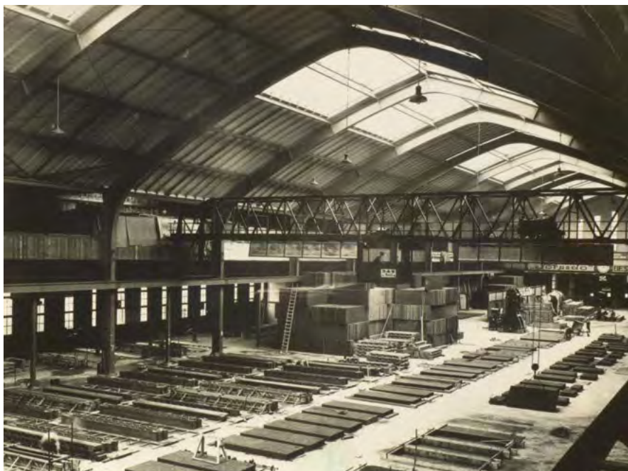
Plattenfabrik mit Laufkran im Haus der Technik, Frankfurt am Main, um 1927 (DKA, NL Ernst May, I,B-9)
