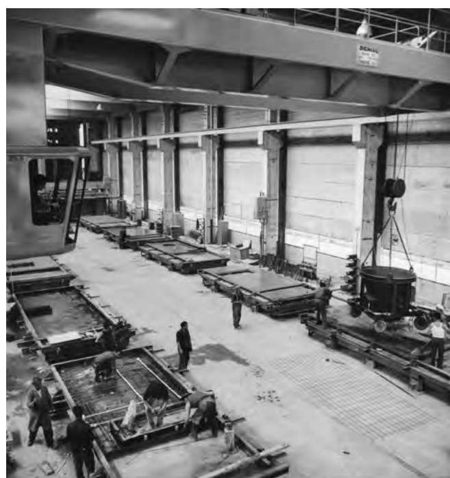
Fertigteilewerk Hinteregger in Neufahrn: Formtische der Werkhalle, Einlegen der Armierung, Einbringen des Betons (Foto: Otto Wasow, Hinteregger, Neufahrn)
